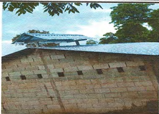
Foto 1: Mantenimiento de techo de la cocina
