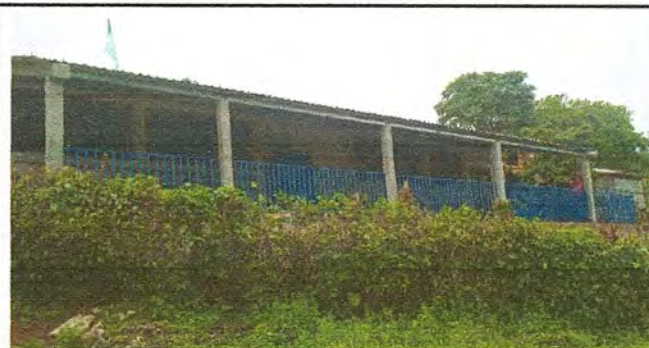
Foto 4: Mantenimiento de puertas y ventanas
