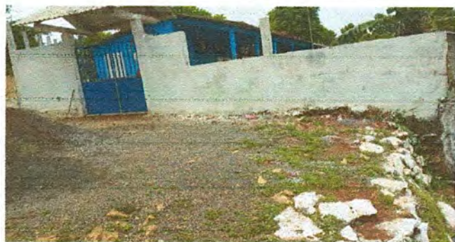
Foto 3: Mantenimiento del portón
