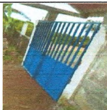
Foto 6: Mantenimiento del portón
