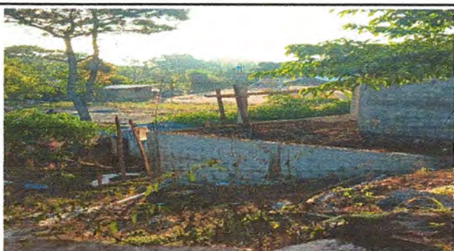
Foto 5: Levantado de muro
